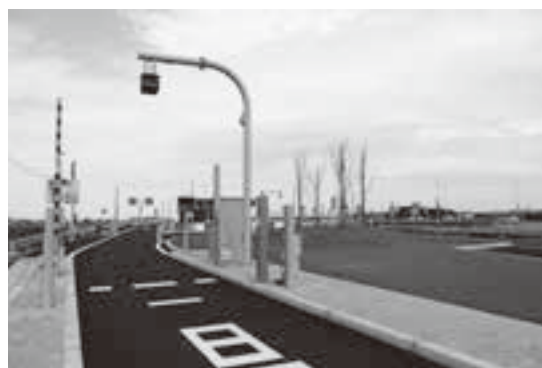
鳥の海スマートICの第1ゲート。奥の第2ゲートを通過して常磐自動車道へ接続します。
