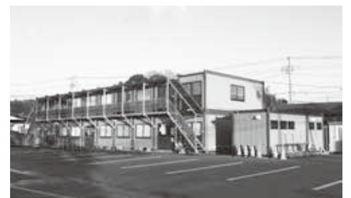
元の庁舎があった場所に建つ仮設庁舎
