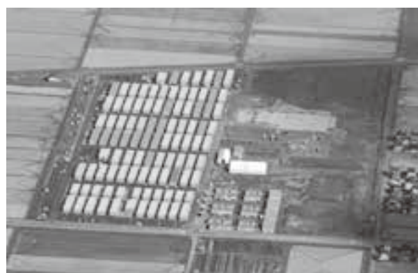
新庁舎建設予定地の公共ゾーン
