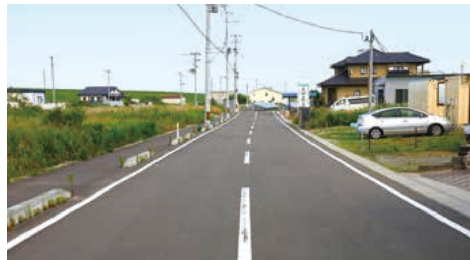
現在の荒浜小学校交差点より東を望む (令和6年6月撮影)
