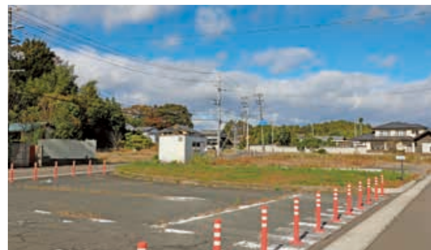
現在の国道6号下大畑ロータリー(令和6年11月撮影)
